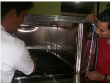
Installation et dernier contrôle
